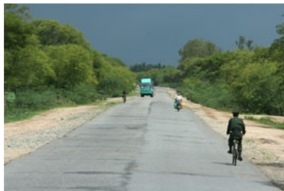
(写真右) 路肩が崩れていることもない
