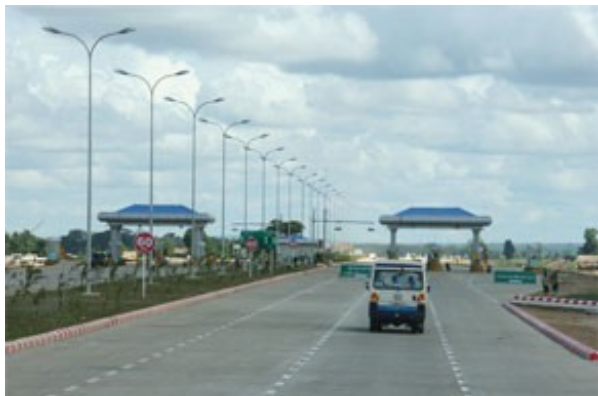
(写真左)ネーピードーの料金所
