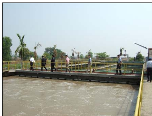
工業団地汚水処理施設
