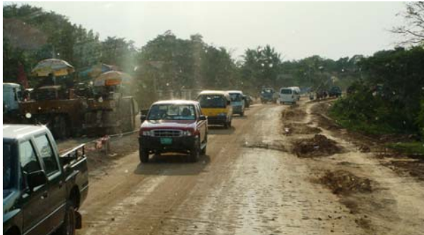
第2東西経済回廊（バベットープノンペン間）ルート上のカンボジア国道1号線は、道路が一部未舗装のため工事中。
